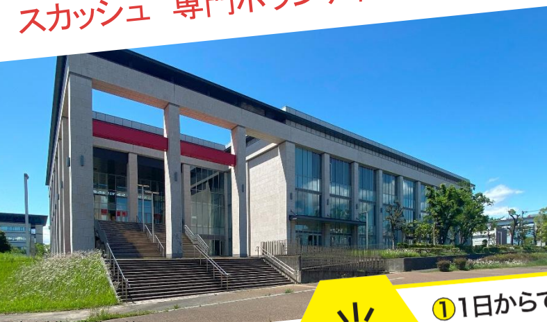
写真は改修工事前の外観
